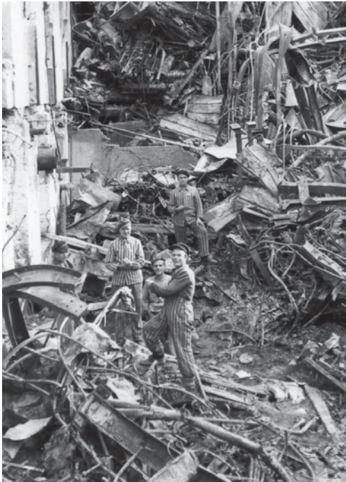
8 KZ-Häftlinge in den Trümmern des südlichen Hochhauses der Spinnerei und Weberei Kottner an der Iller, in welchem bis zu dem Luftangriff auch teilweise für Messerschmitt/Werkzeugbau Kottner gefertigt wurde.
