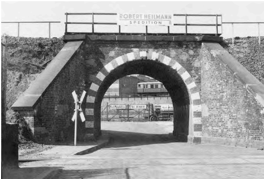
Güterbahnhof Moabit Quitzwowstraße, Zuwegung mit Unter- führung unter Ring- bahn-Gütergleisen, davor Militärgleis 69 mit angeschnittener Rampe 1977. Foto: Peter Bley
