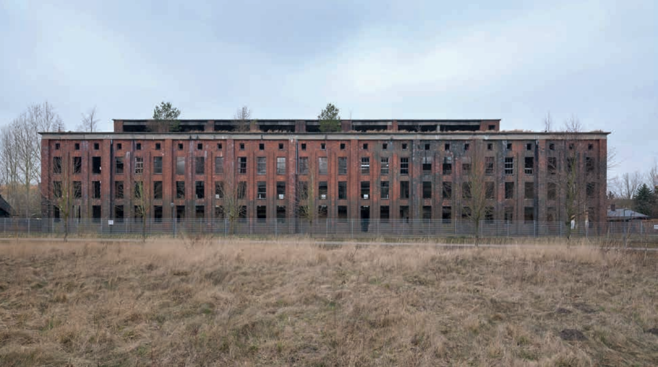
Abb. 1: Ruine des Sauerstoffwerks, 2022. Foto: Lorenz Kienzle
