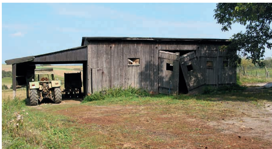
Die einsturzgefährdete, ehemalige Busgarage kurz vor ihrem Abbau, September 2002. Gedenkstätte Hadamar, Fotosammlung
