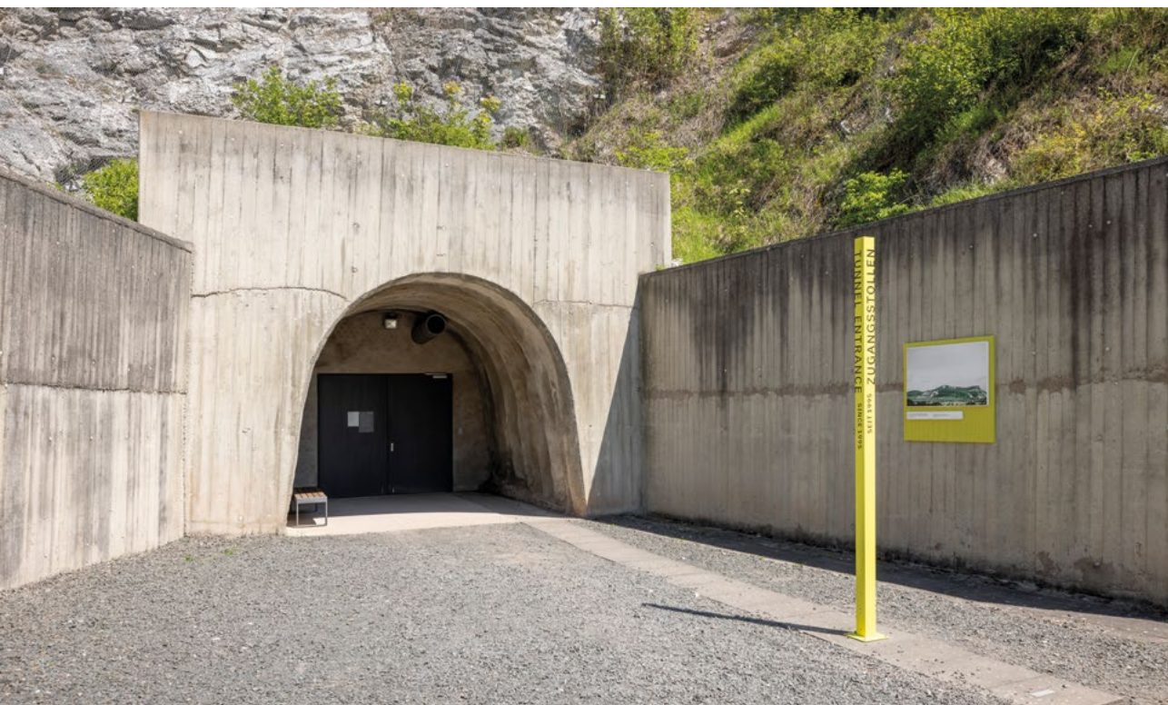
Blick auf Elemente des neuen Erschließungssystems am Zugang zur Stollenanlage der KZ-Gedenkstätte Mittelbau-Dora
