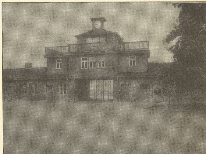
Hauptgebäude (vom Appellplatz aus gesehen)
