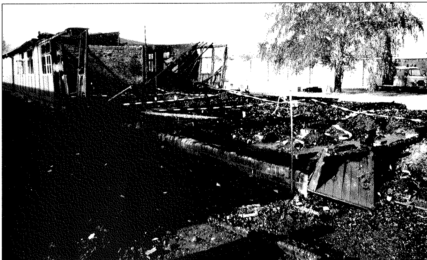
Baracke 38 nach dem Brandanschlag, 1993.
