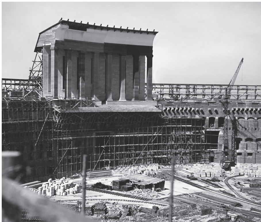
Baustelle Kongreßhalle mit Modellelement aus Holz, 1937 Quelle: Städtisches Bild-, Film- und Tonarchiv Nürnberg
