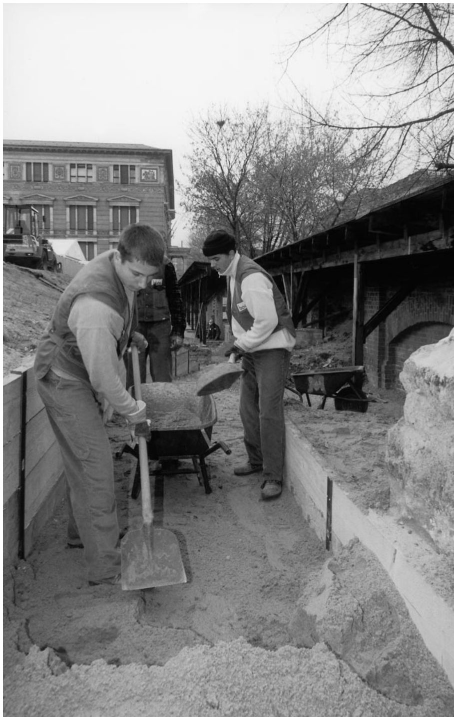
Lehrlinge helfen im Rahmen einer Aktion des Zentralverbands des Deutschen Bauhandwerks bei der Einrichtung der Open-Air-Ausstellung, 1998. Foto: Hans D. Beyer/Stiftung Topographie des Terrors
