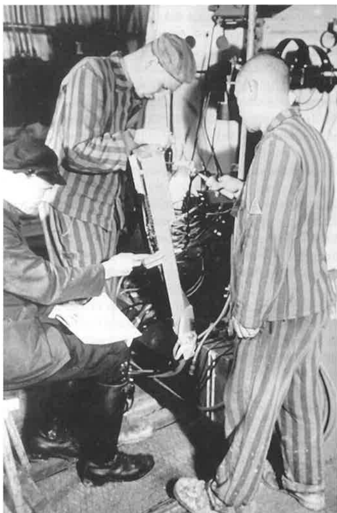
KZ-Häftlinge aus dem KZ Mittelbau-Dora beim Einbau des elektrischen Haupt-verteilers in den Geräteraum der V2 (1944). Foto: Walter Frentz Ullstein-Bilderdienst
