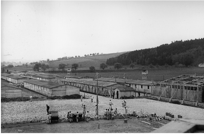
Bau des Appellplatzes, ungefähr Frühjahr 1940 Foto: SS-Foto, Courtesy of Museu d'Història de Catalunya, Barcelona: Fons Amical de Mauthausen
