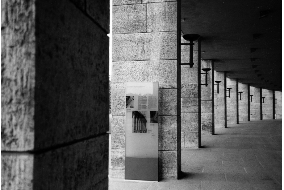
Pfeilerhalle des Stadion-Umgangs mit Flammenschalen- Leuchten und Kommentierungstafel
