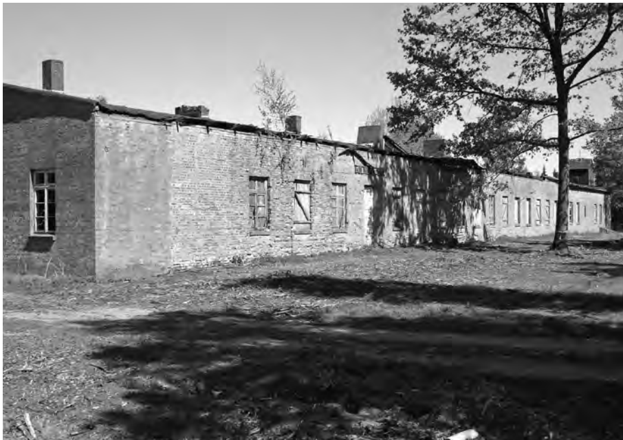
Oben: Ansicht der hölzernen Unter- kunftsbarracken Unten: Ansicht der ehem. Lagerküche. Der Schriftzug »Bücher- stube« der in der Gebäudemitte zu erkennen ist, stammt aus der Nutzungsphase als Durchgangslager für DDR-Flüchtlinge. Fotos: Andreas Ehres- mann, April 2007
