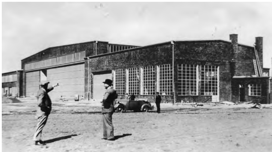
Eine Flugzeughalle auf dem Fliegerhorst Barth. 1943 wurde sie zusammen mit sieben weiteren zur Produktionshalle des KZ-Werkes umfunktioniert. Foto: Stadtarchiv Barth, Reproduktion Holger Friedrich
