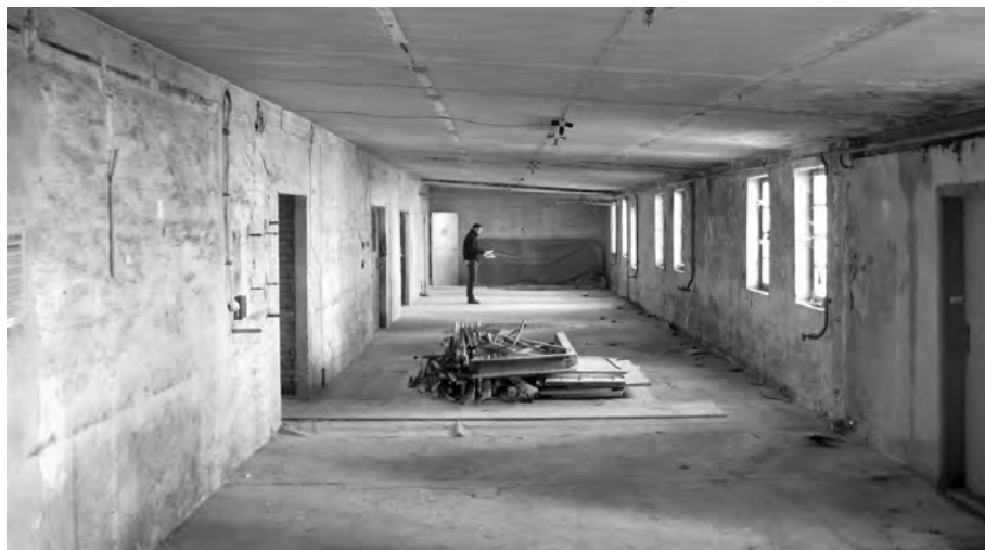
Innenraum Baracke 13 vor der Sanierung, 2009. Foto: W. Vilain
