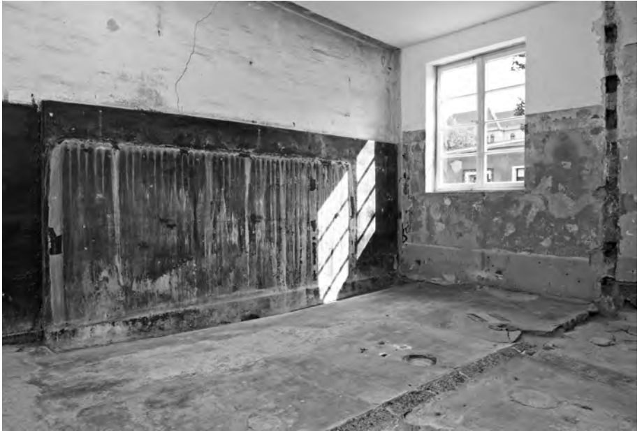
Blick in den Toilettenraum mit erhaltenen Spuren der Toiletten, 2011. Foto: Dokumentations- zentrum NS-Zwangs- arbeit, M. Steffen
