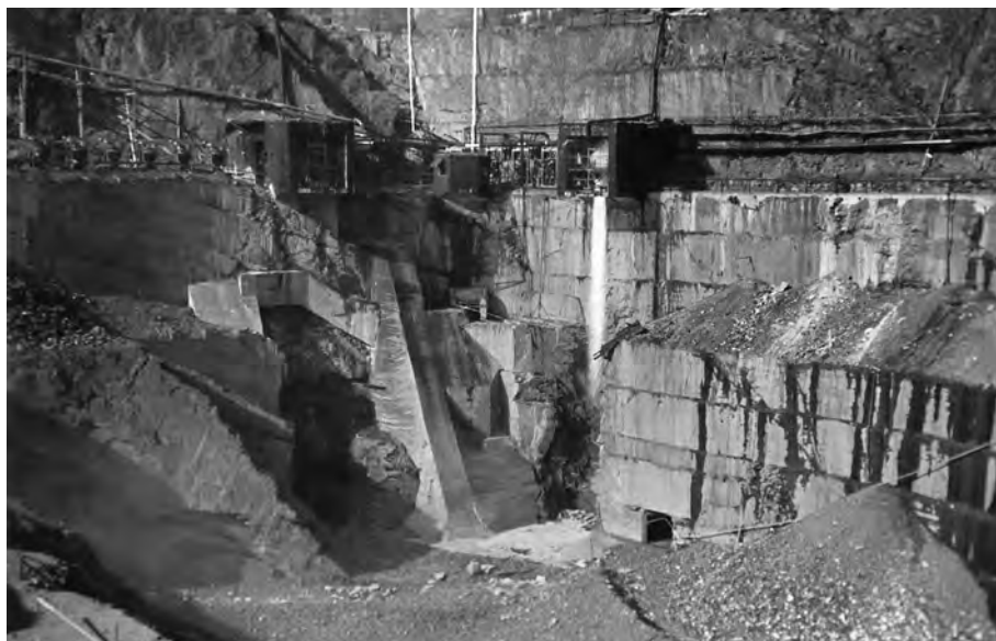
Test eines A4/V2-Triebwerks im Vorwerk Mitte Lehesten 1944. Foto: Nachlass Walter Frenz
