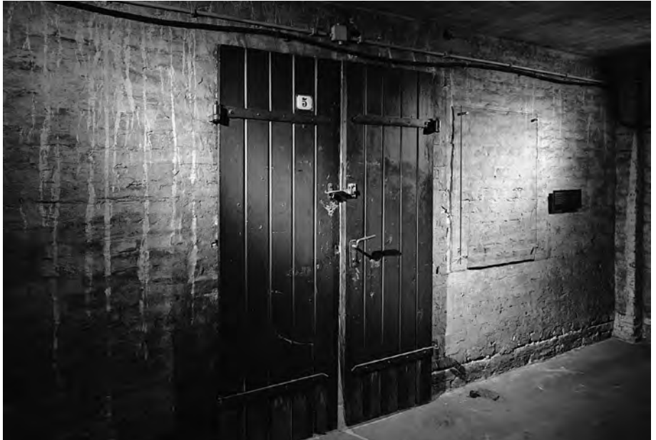
Tür vom Kellergang zum Haftraum 5
