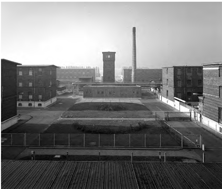
Blick vom Verwaltungsgebäude auf das Innengelände der StVE Rummelsburg, 1990, Quelle: LAB
