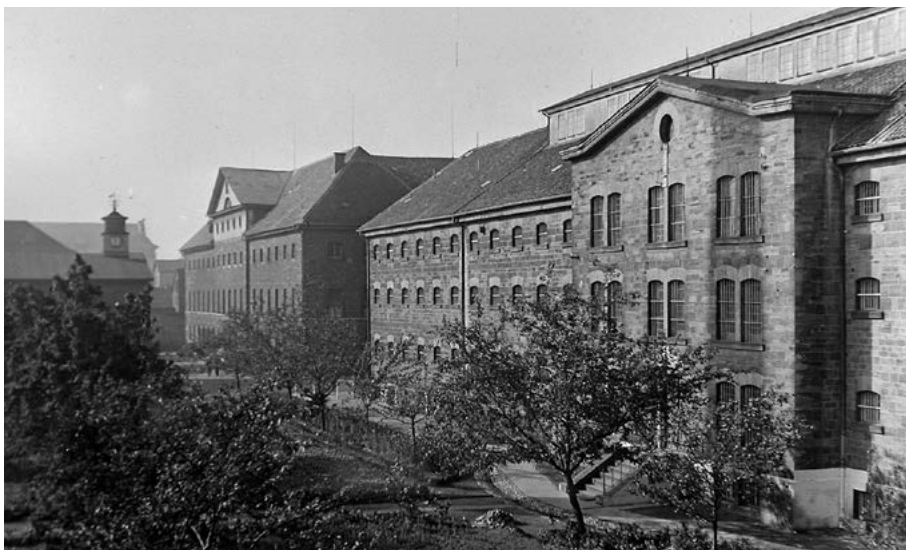
Historische Aufnahme des Strafgefängnisses Wolfenbüttel mit Blick auf die Hafthäuser I und III und das Hinrichtungsgebäude am linken Bildrand, vermutlich 1941. Foto: Niedersächsisches Landesarchiv Standort Wolfenbüttel – 50 Slg 234 Nr. 36
