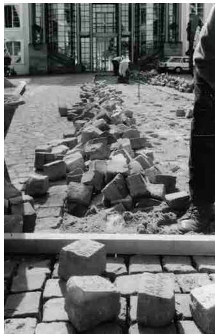
Ansicht der Schlossauffahrt während der Verlegearbeiten im Juli 1992.
