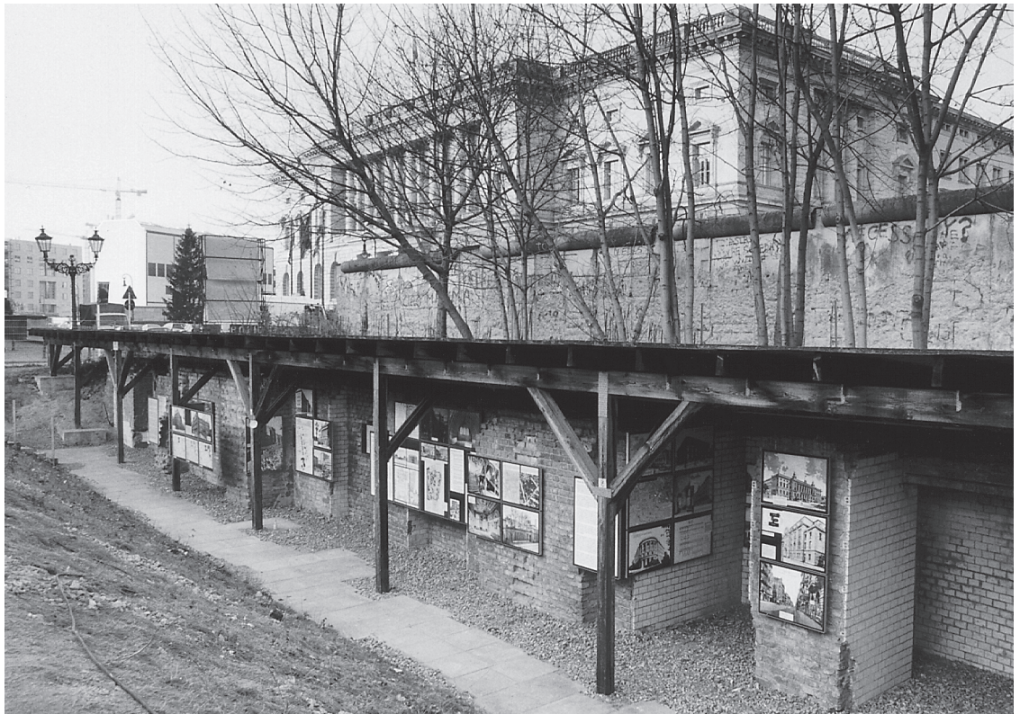
Blick auf die Open-Air-Ausstellung Foto: Hans D. Beyer, Stiftung Topographie des Terrors
