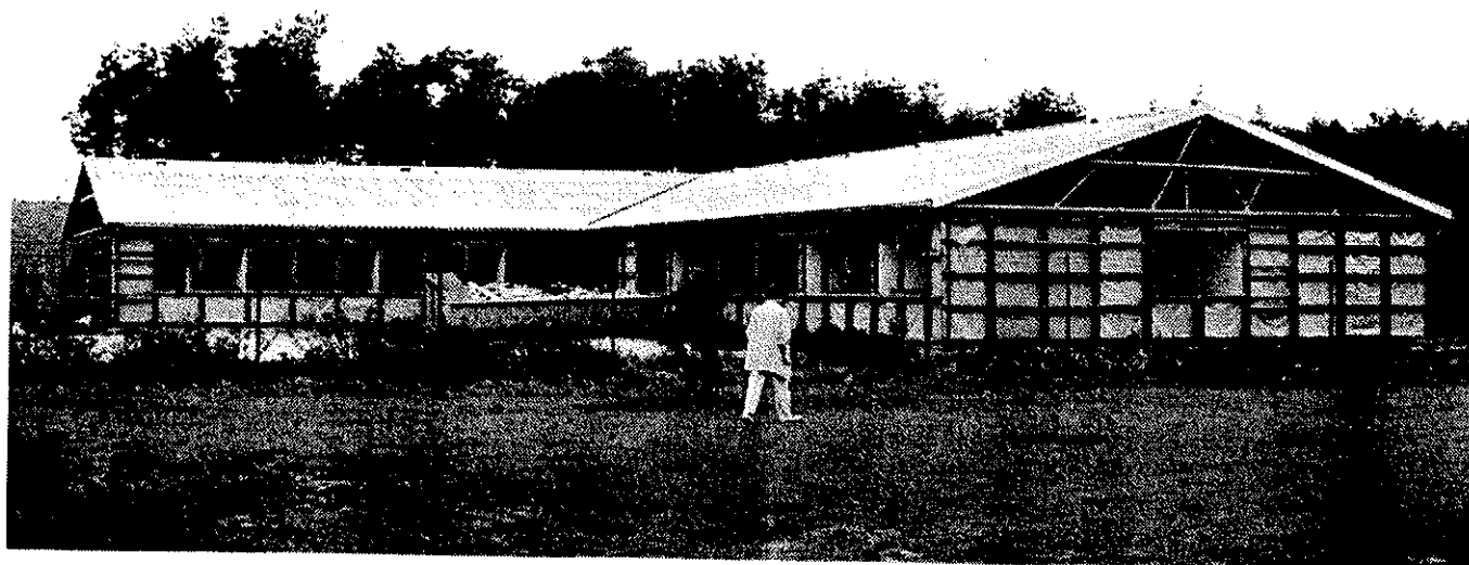
Die Bauleitungsbaracke der "Speicherbecken Geeste OHG" kurz nach Beginn der Demontage.
