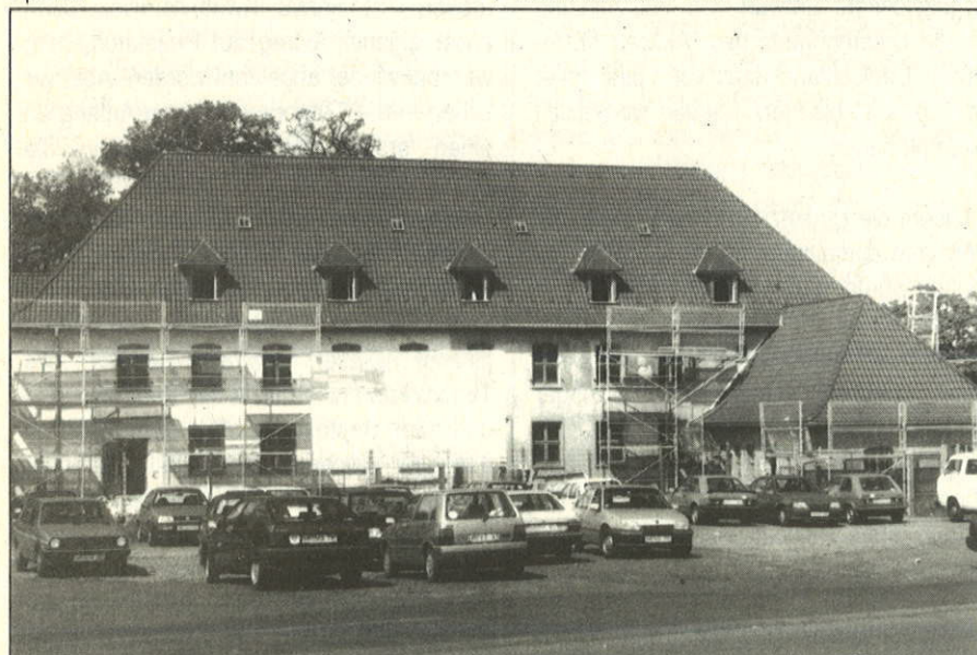
Das DIZ wird im Anbau und einem Teil der Kellerräume untergebracht
