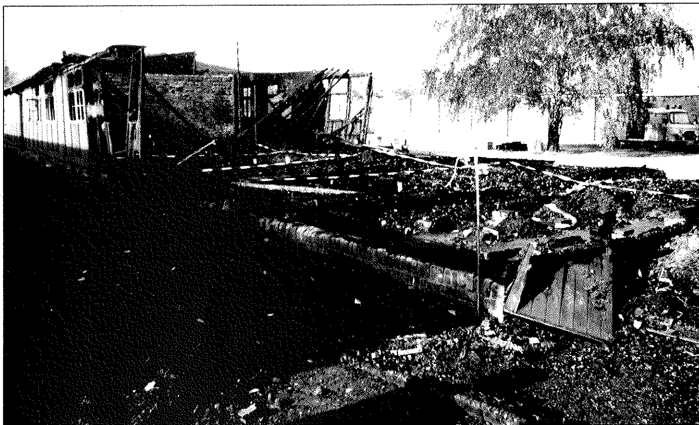
Baracke 38 nach dem Brandanschlag, 1993.
