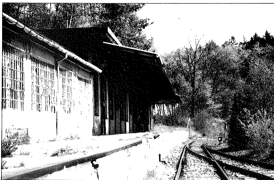
Ehemaliges Lagergebäude und Verladerampe am Bahnring im Werksgelände. Aufnahme 1995.
