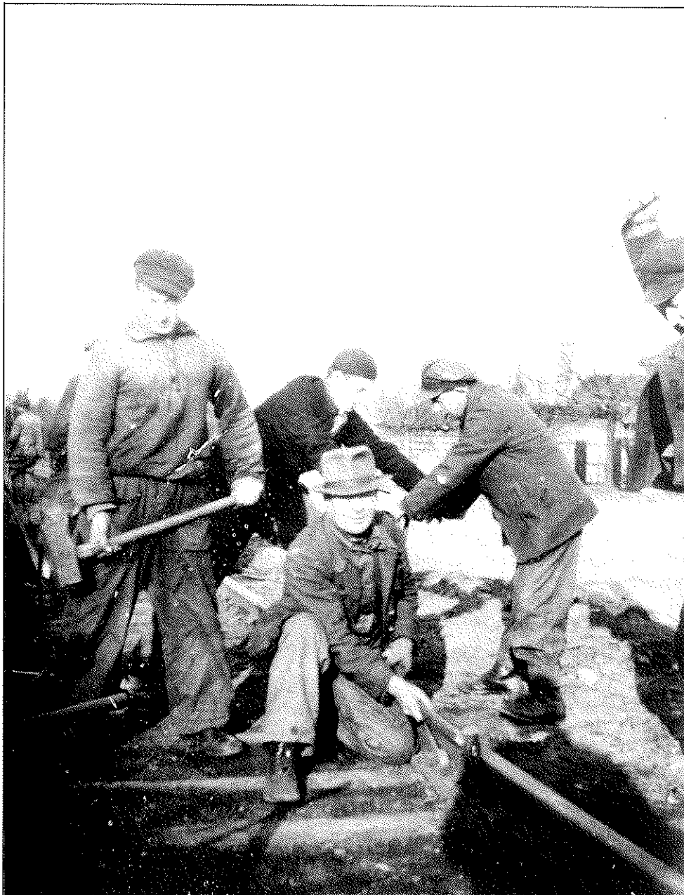
Polnische Zwangsarbeiter bei Gleisbauarbeiten (1942).
