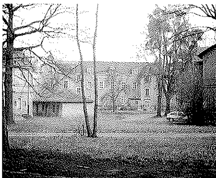
Pirna-Sonnenstein, Bereich der Vergasungsanstalt, Blick von Süden auf Haus 14 (vor 1945 Haus 16). Foto: Kuratorium Gedenkstätte Sonnenstein, 1995
