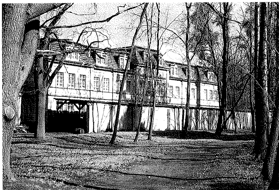
Pirna-Sonnenstein, Verwaltungsgebäude und Mauerrest der ehemaligen Tötungsanstalt. Foto: Kuratorium Gedenkstätte Sonnenstein, 1996
